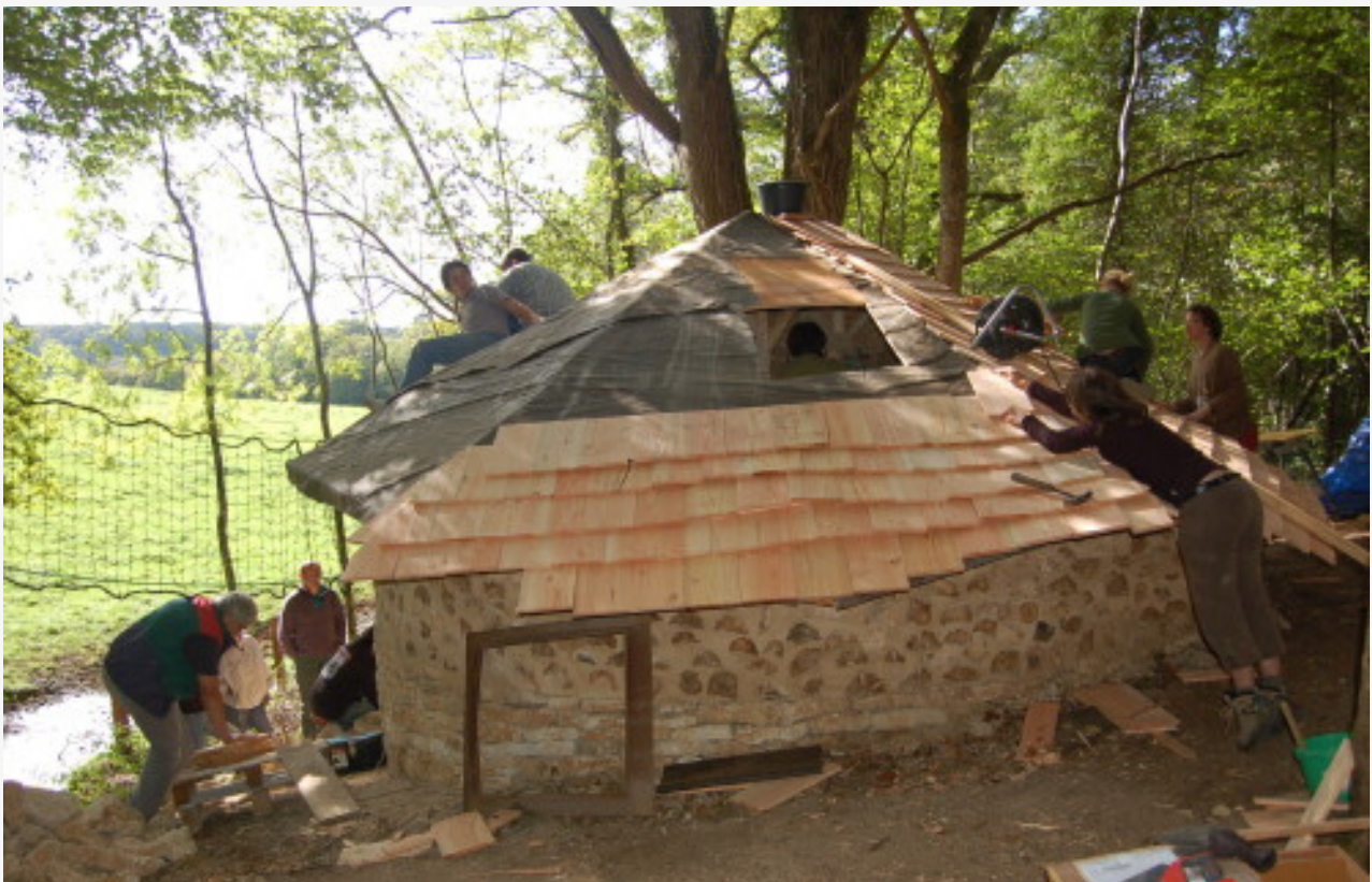
Chantier participatif pour la construction d'une cabane, CIN Auberive
